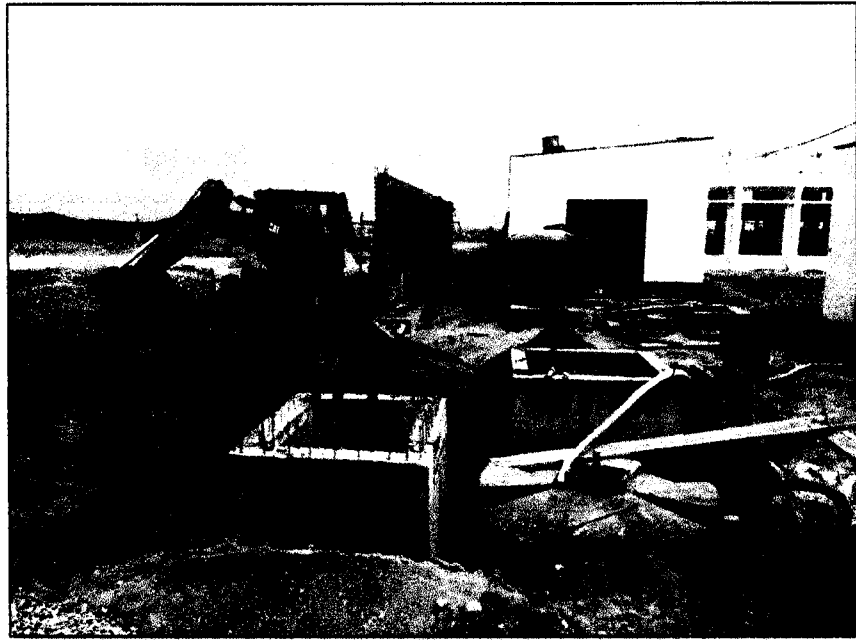
Acarreo del material de excavación en la zona del biodigestor
